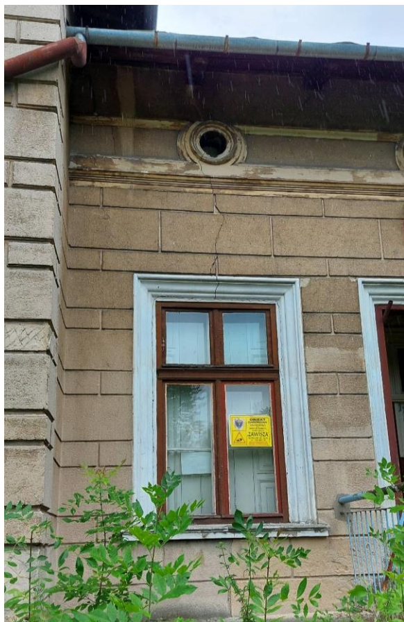
Fot.6.-7. Okno elewacji frontowej z widocznym pęknięciem, źródło: własne
