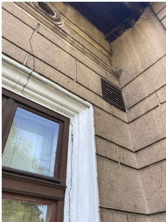
Fot.6.-7. Okno elewacji frontowej z widocznym pęknięciem, źródło: własne
