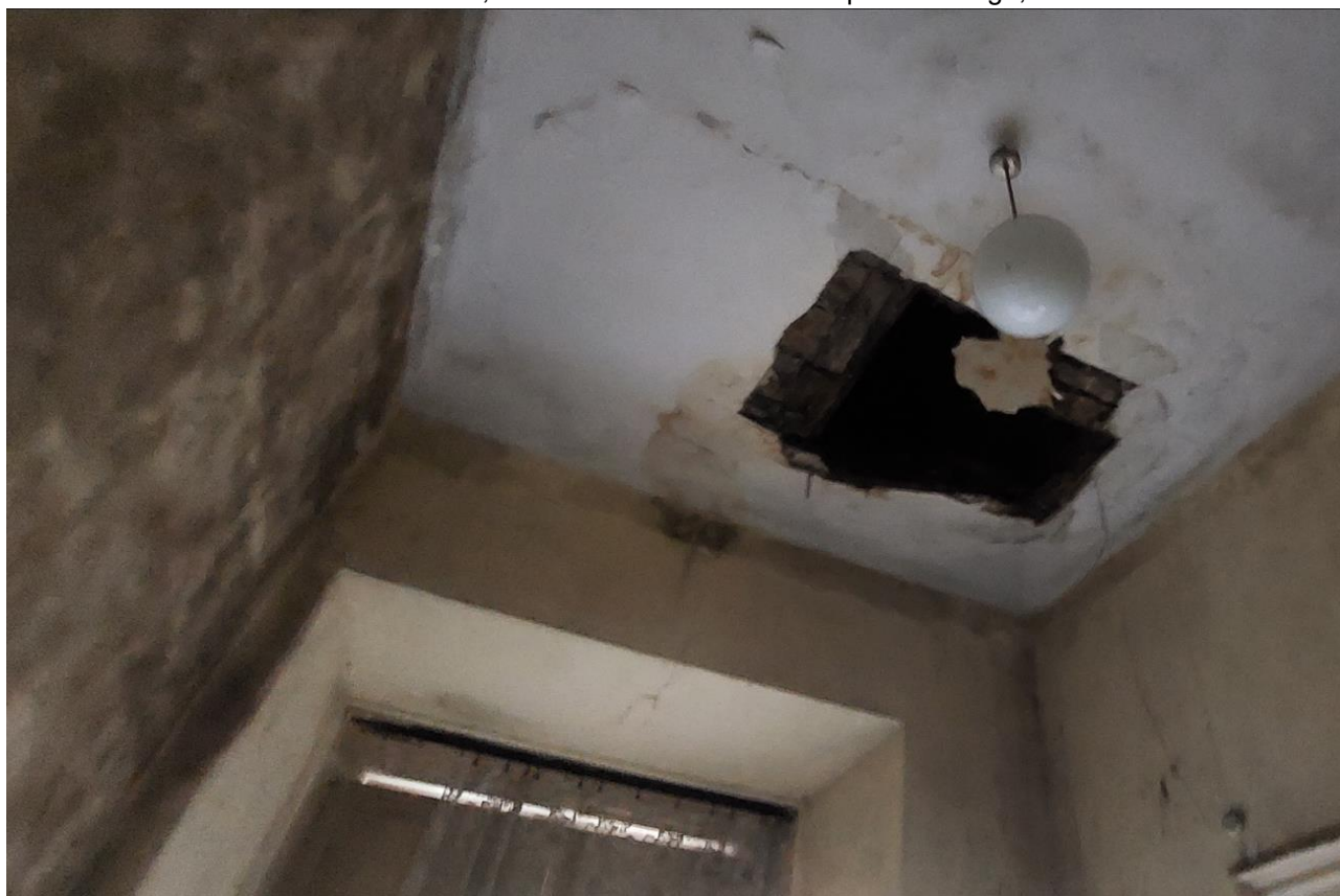
Fot.21. Fragment zawalonego stropu, pom. 0.5, źródło: własne
