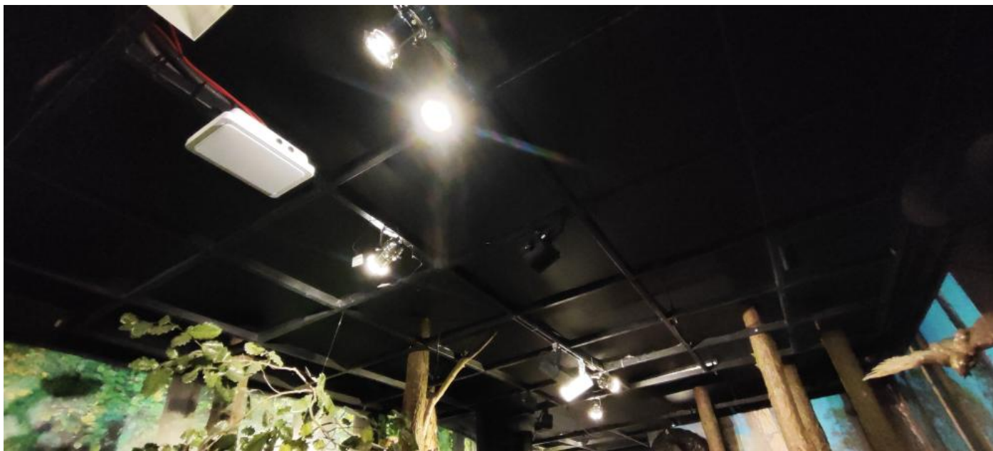
widok na kratownicę
