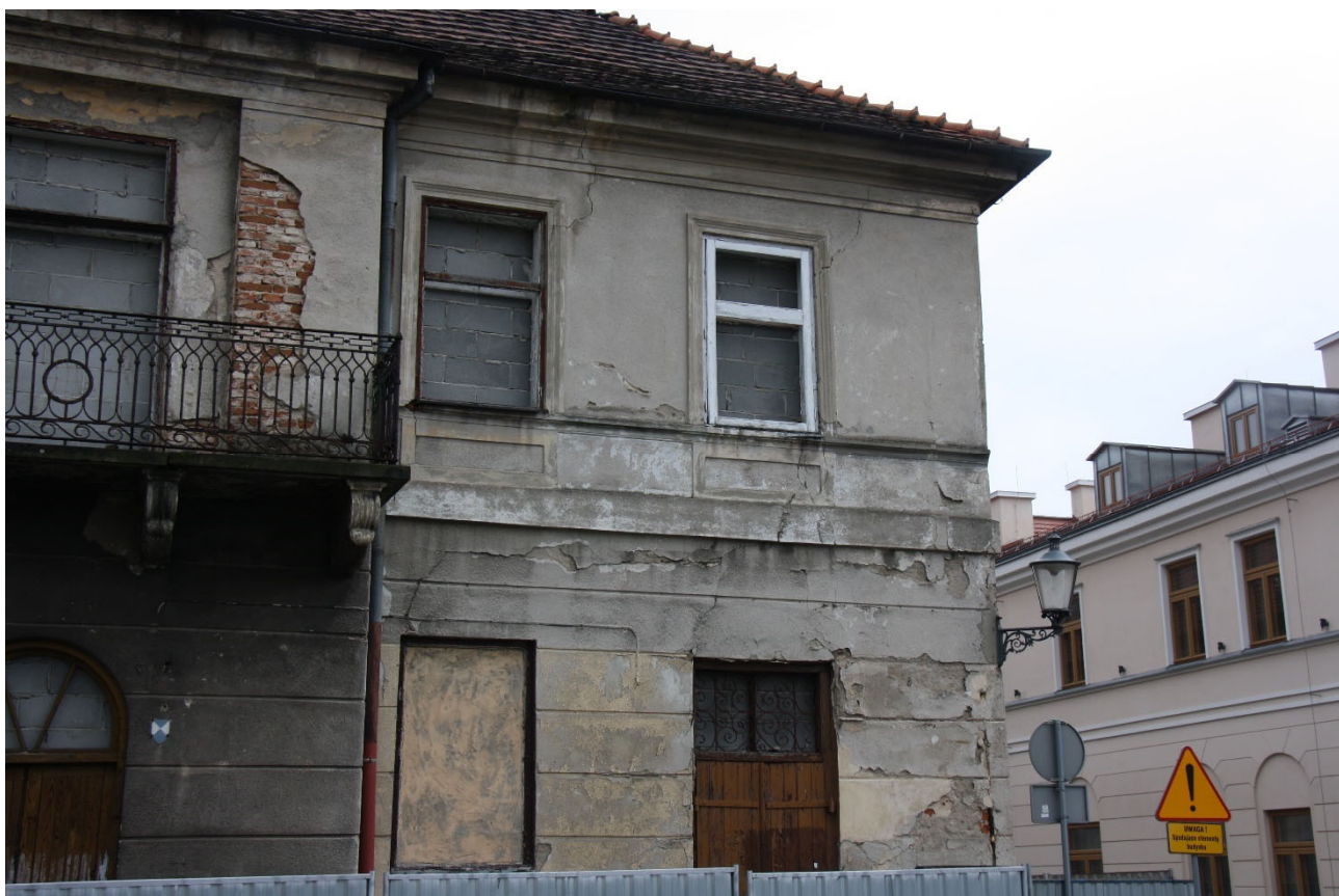
Fot. 16. Ściana zachodnia z widocznymi, licznymi pęknięciami konstrukcji murowej.
