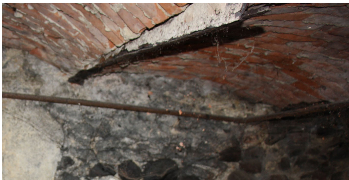
Fot. 8. Wysunięta belka ze stropu odcinkowego.
