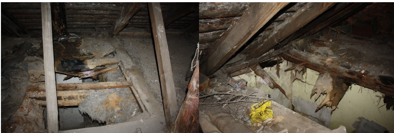
Fot. 23. Stan techniczny stropu nad I piętrem – widok z poziomu strychu.
