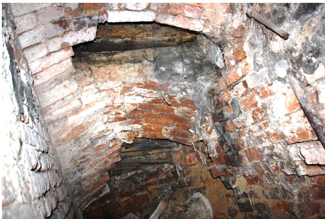
Fot. 10. Uszkodzony strop nad piwnicą pod wejściem.
