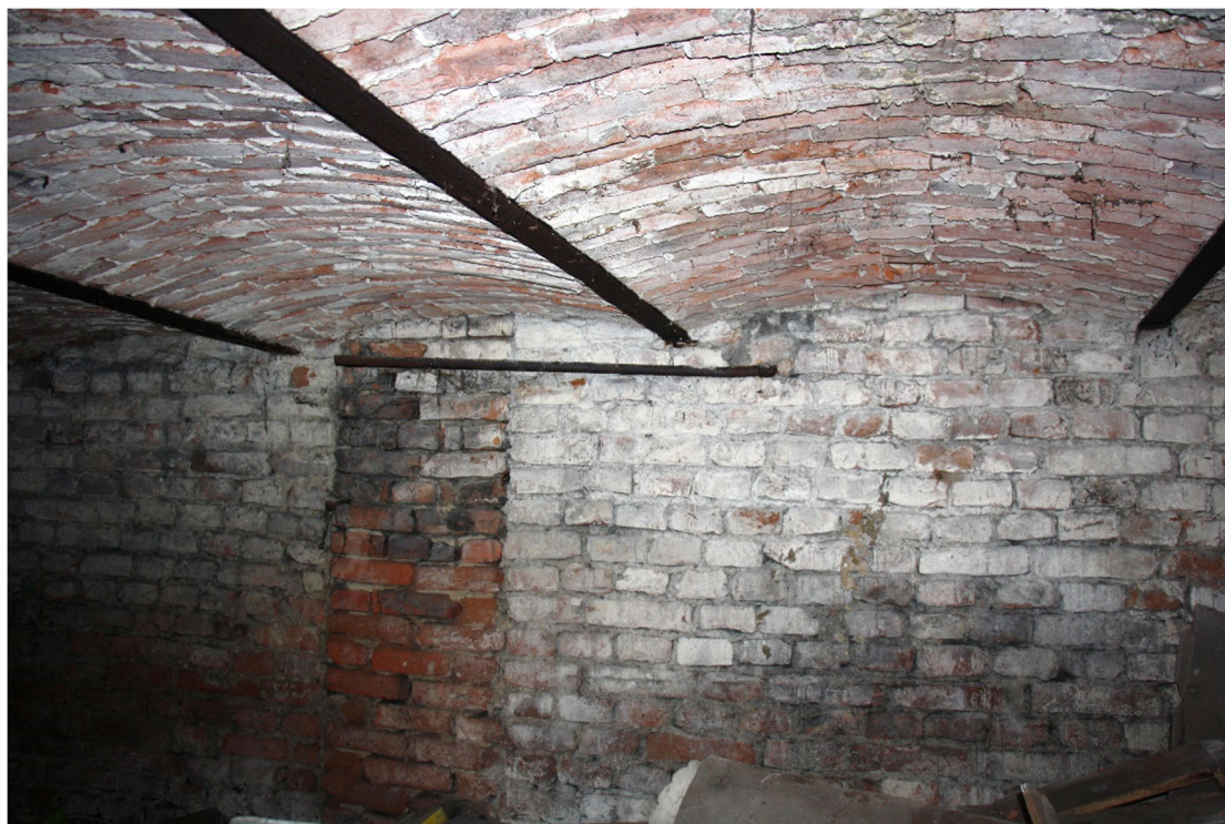
Fot. 12. Stan zachowania stropu odcinkowego – piwnica południowa, część wschodnia.
