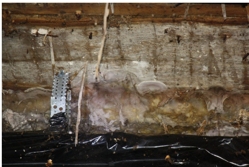
Fot. 21. Zawalony strop – część zachodnia, widoczne rozwinięte ogniska pleśni i grzybów.
