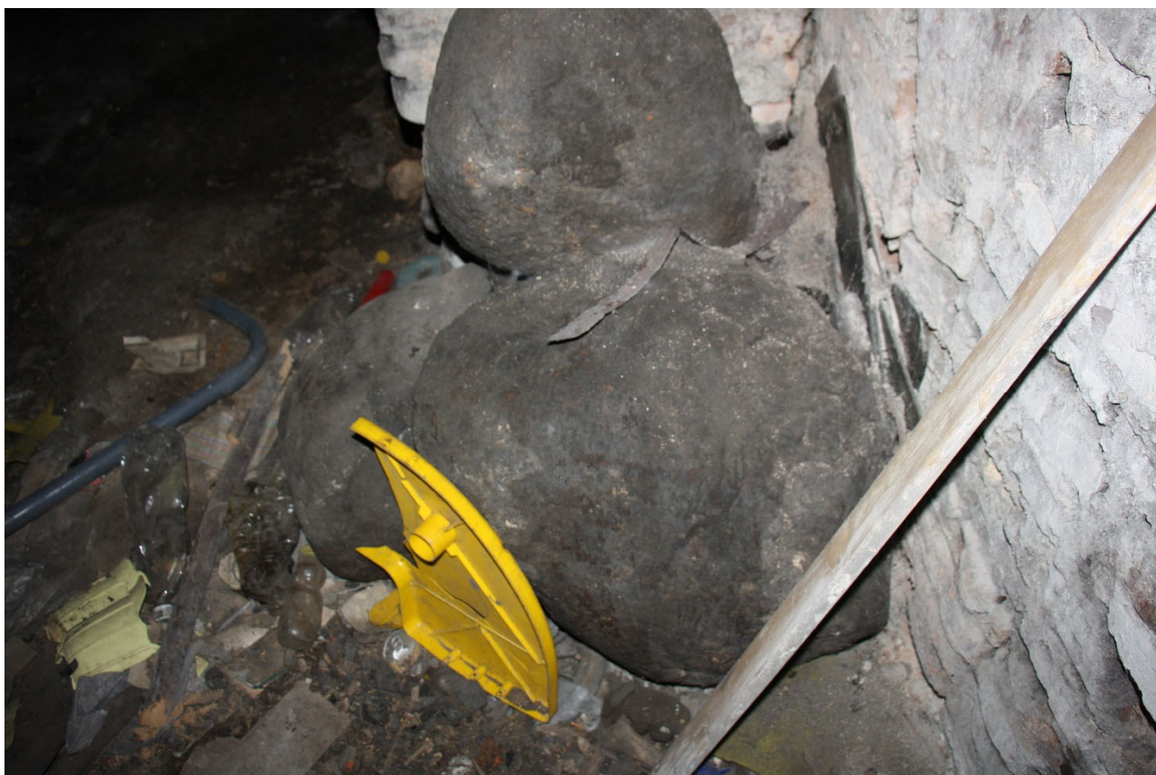
Fot. 2. Kamienie konstrukcyjne wyjęte ze ściany – część zachodnia piwnic.
