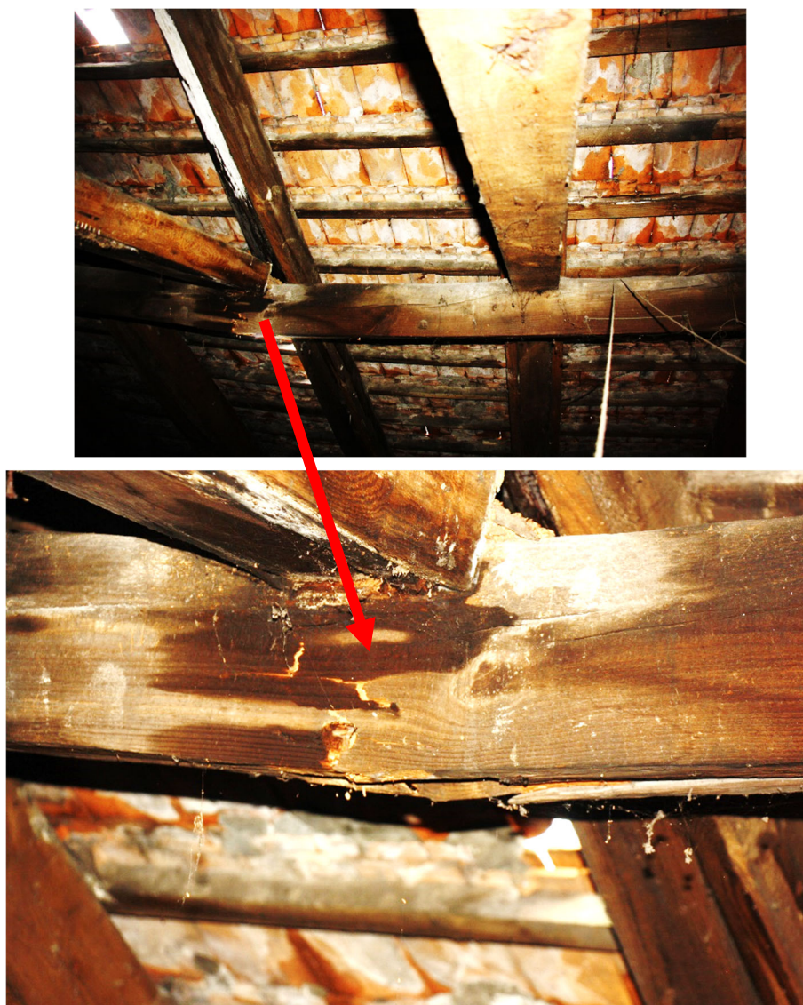
Fot. 24. Pęknięta płatew konstrukcji dachowej.
