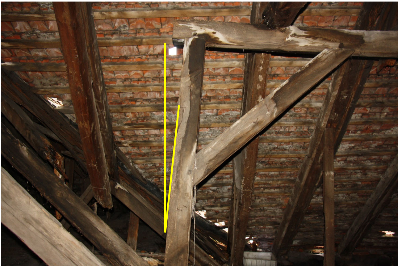
Fot. 31. Nadmierne ugięcie płatwi i odchylenia słupa.
