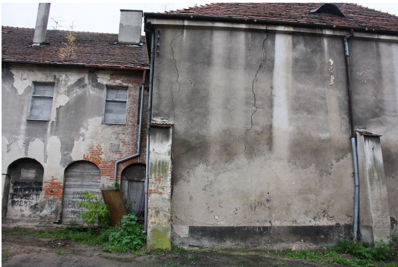
Fot. 17. Ściana północna od strony Rynku – widoczne pęknięcia na całej wysokości.
