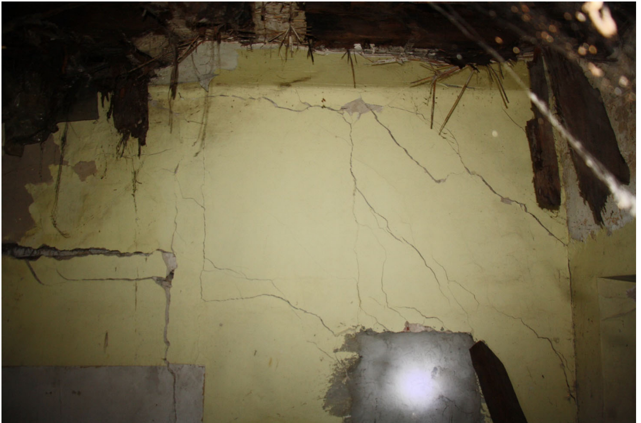
Fot. 19. Pęknięcia ściany na styku z budynkiem przy ul. Rwańskiej 1 (I piętro).
