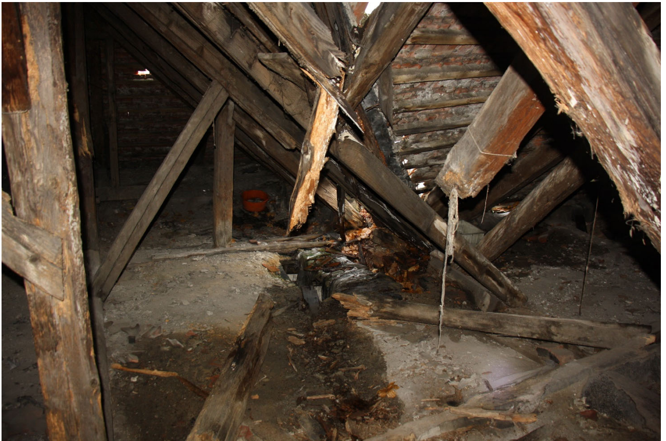
Fot. 29. Uszkodzone (luźne) elementy konstrukcji dachowej.
