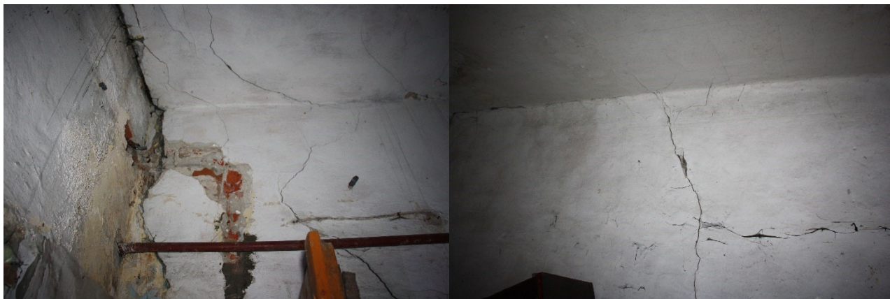
Fot. 18. Spękana konstrukcja ściany i stropu – ściana zachodnia zewnętrzna na I piętrze.
