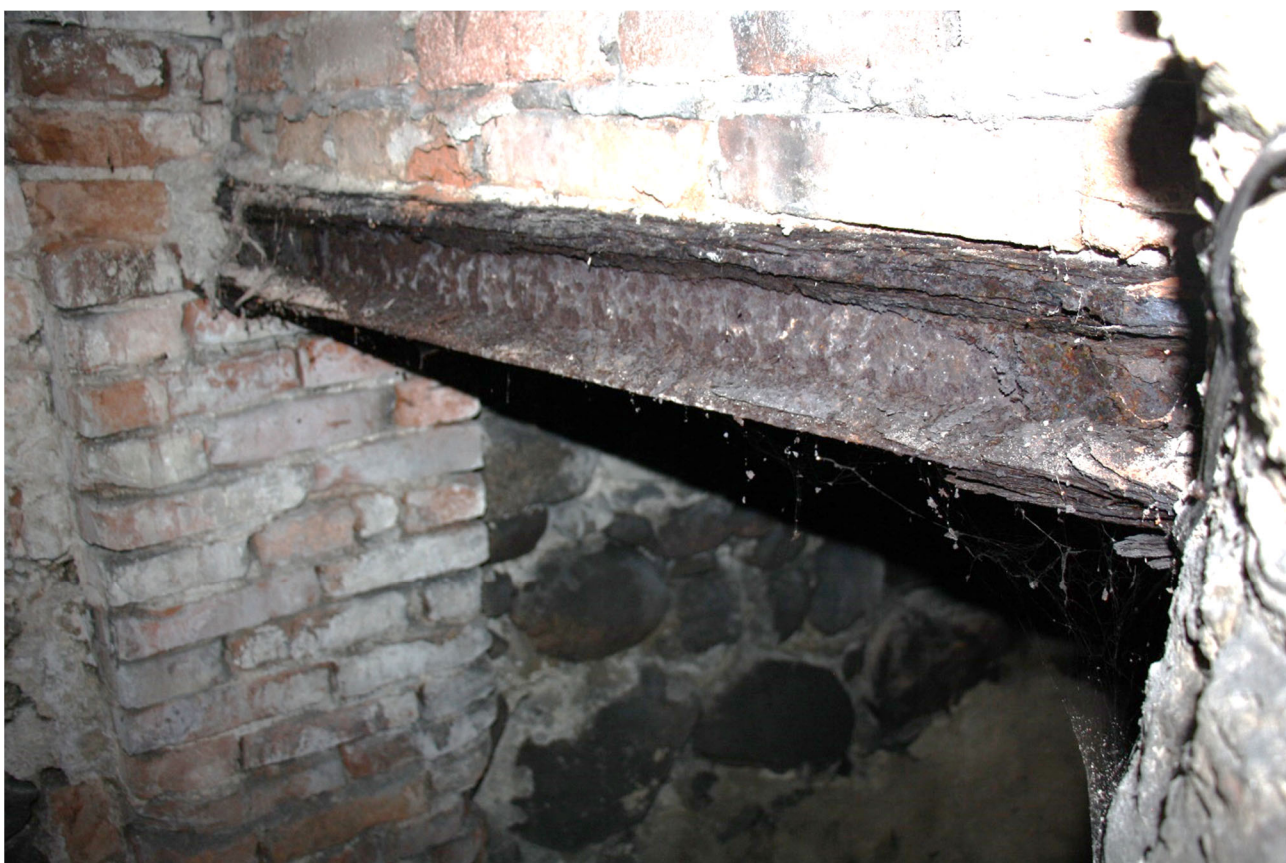
Fot. 7. Stan techniczny belki stalowej – prawdopodobnie wtórnego wzmocnienia konstrukcji murowej.
