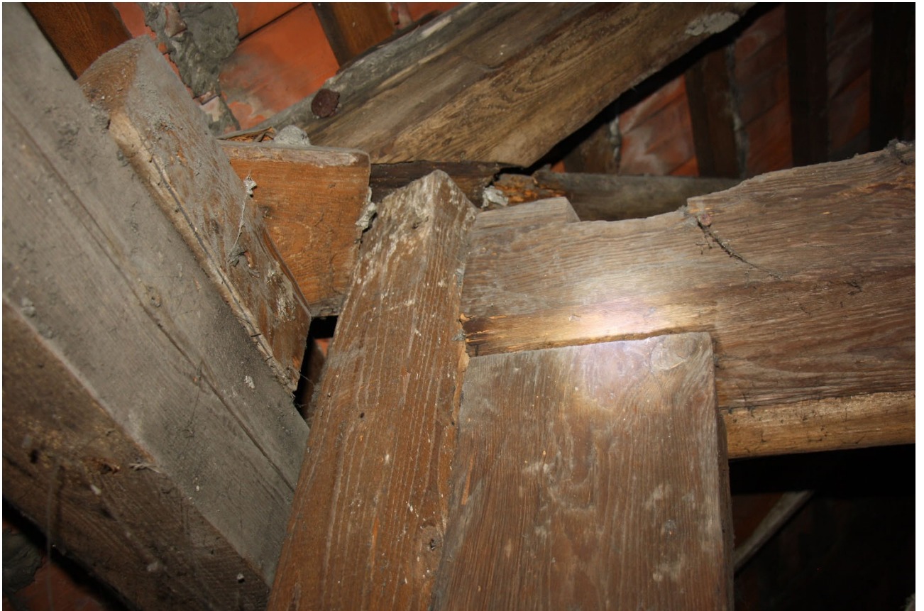
Fot. 30. Znaczne przemieszczenia w węźle konstrukcji.
