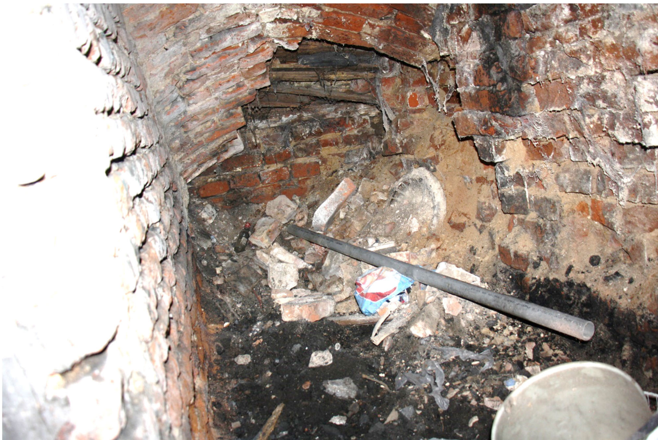
Fot. 4. Pęknięcia ściany przy zamurowanym przejściu do ślepej piwnicy.
