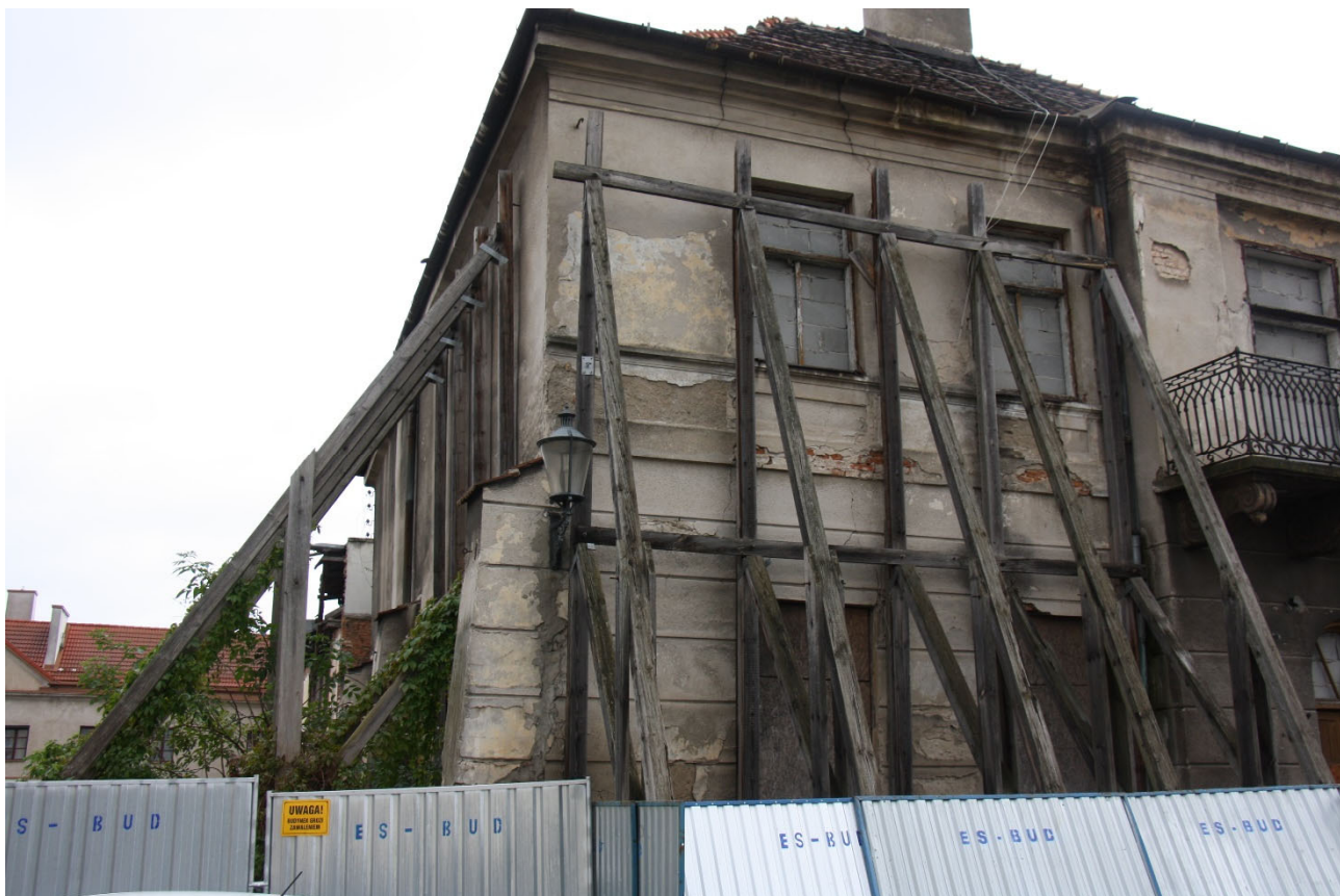
Fot. 14. Zabezpieczenie ściany północnej oraz zachodniej krawędziakami.
