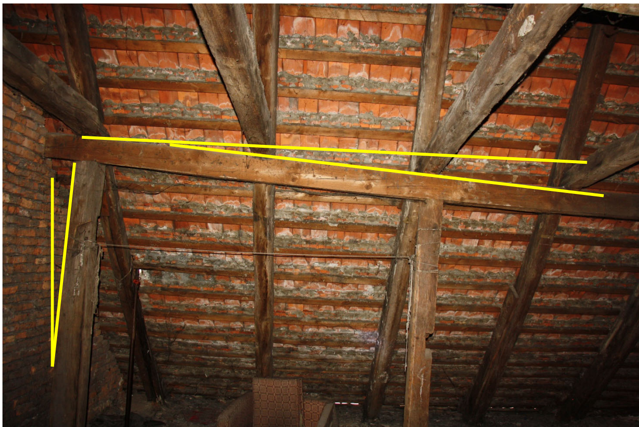
Fot. 27. Nadmiernie ugięta płatew z odchylonym od pionu słupem.
