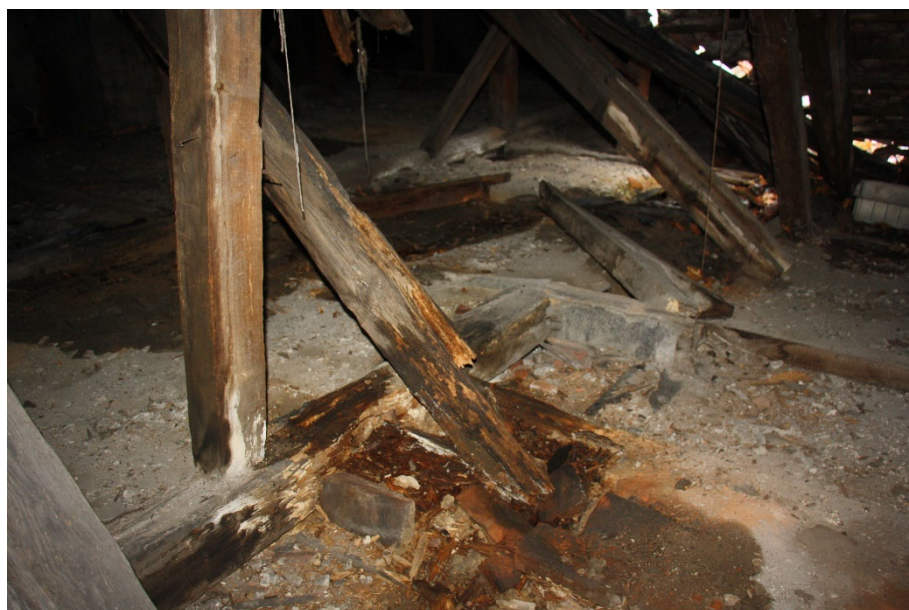
Fot. 28. Przegnicie oparcia elementów konstrukcyjnych.
