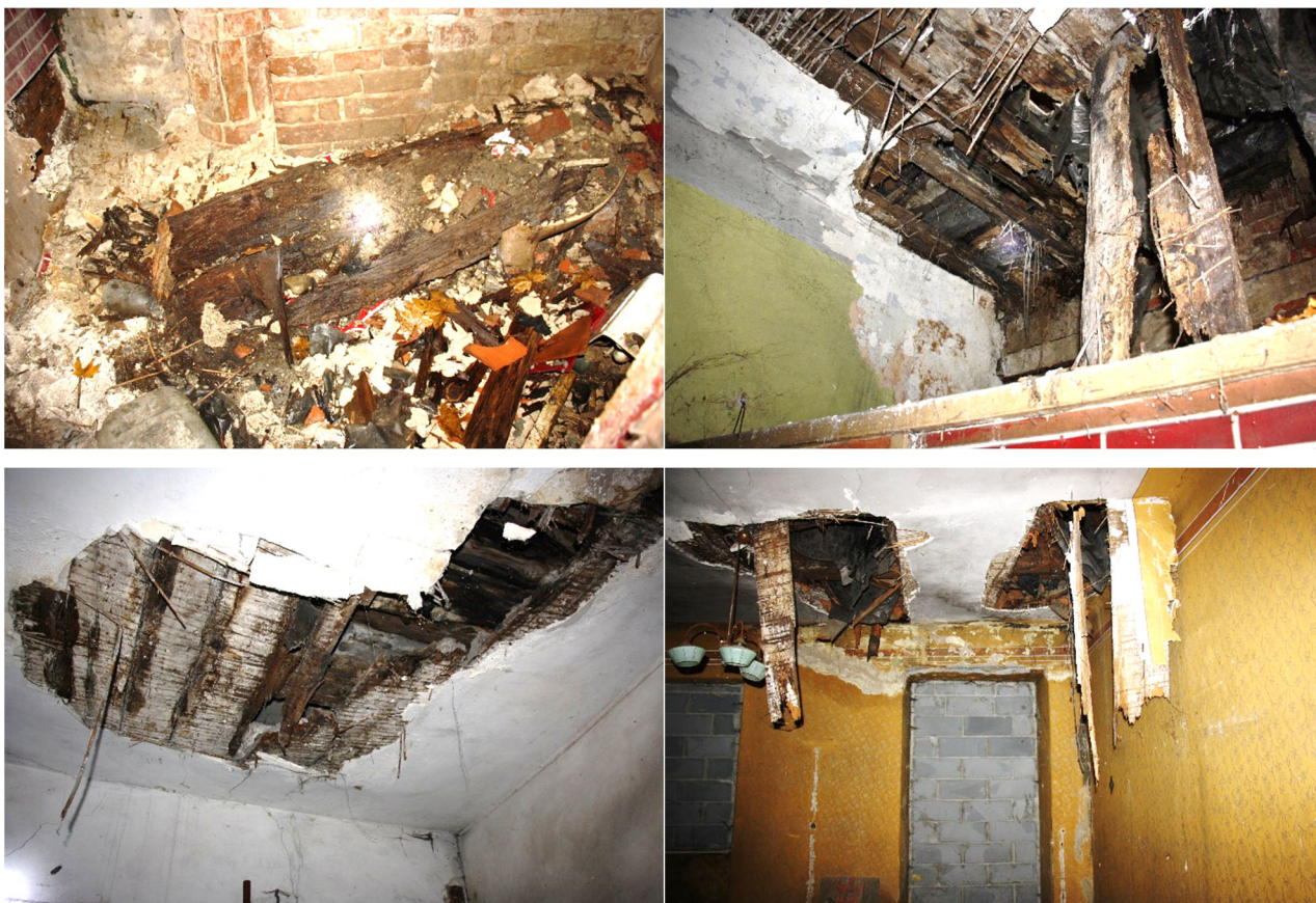
Fot. 22. Stan techniczny stropu nad I piętrem – widok z kondygnacji I piętra.
