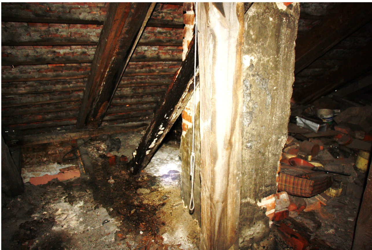
Fot. 26. Porażenie elementów konstrukcyjnych grzybem.
