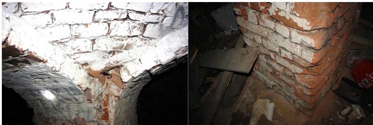
Fot. 13. Stan zachowania sklepienia w piwnicy narożnej, południowo-wschodniej.
