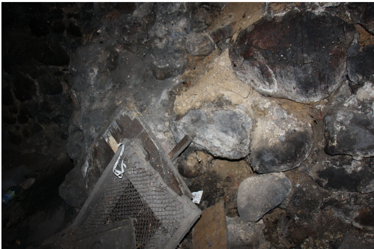
Fot. 2. Kamienie konstrukcyjne wyjęte ze ściany – część zachodnia piwnic.
