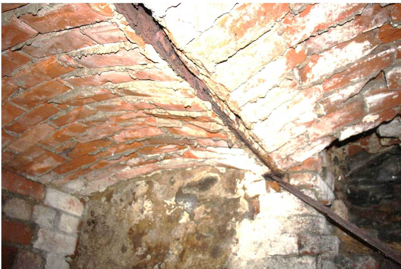
Fot. 9. Całkowita perforacja półki dolnej w stropie odcinkowym.
