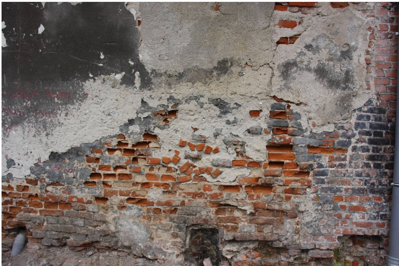
Fot. 15. Ściana północna, widoczna uszkodzona cegła, murowana często w sposób przypadkowy.
