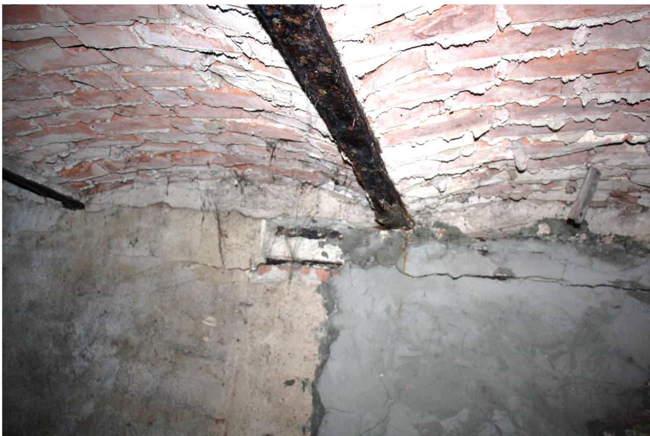
Fot. 4. Pęknięcia ściany przy zamurowanym przejściu do ślepej piwnicy.
